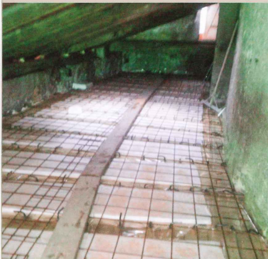
← PALAZZO CAVAGNA. Consolidamento del solaio in legno dell'ala est a piano sottotetto mediante cappa estradossale e connettori
