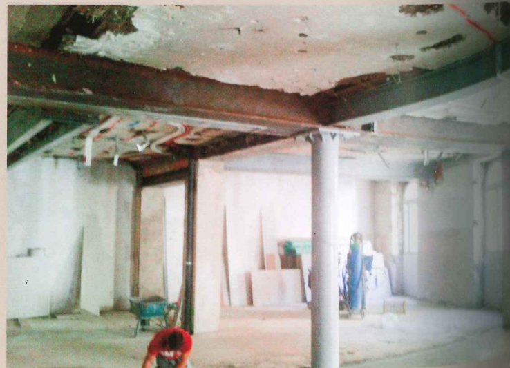
← PALAZZO CAVAGNA. Consolidamento del solaio in legno dell'ala est a piano sottotetto mediante cappa estradossale e connettori
